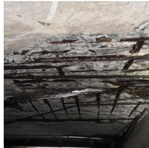
写真1：床版の鉄筋露出（健全度判定III）
