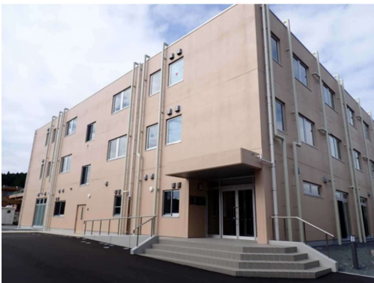
外観(入口付近から)
