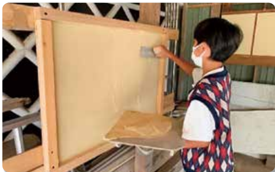
「こて」を使った壁塗り体験 （空き家リノベーションワークショップ）
