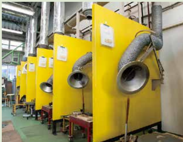
溶接場 Welding Corner
